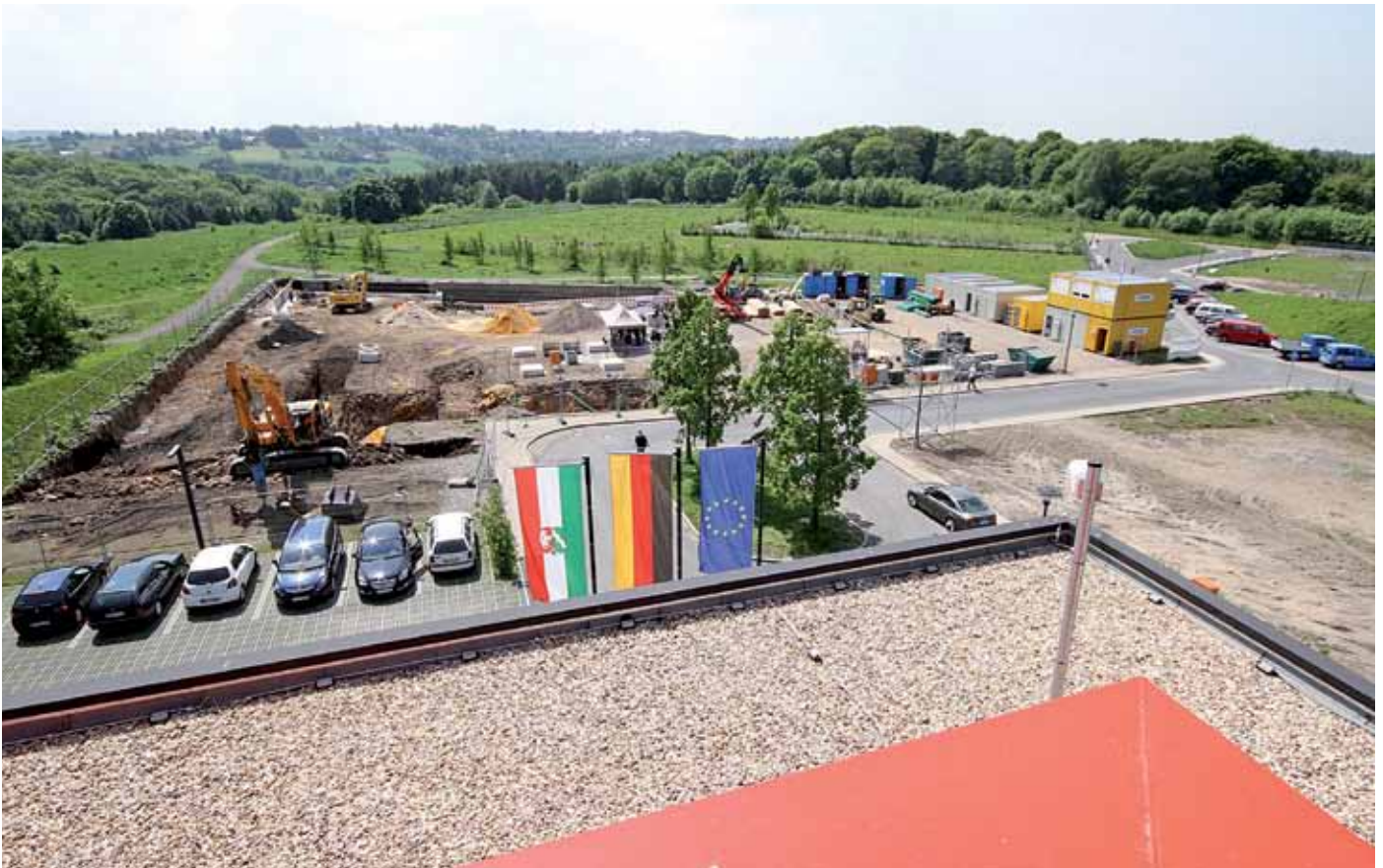
Ein Blick vom Dach des Landesgesundheitszentrums in Richtung Baustelle zeigt den künftigen Standort der Aesculap-Akademie. Bereits im April nächsten Jahres sollen hier die ersten Kurse stattfinden. fobo-Bild: Molatta
