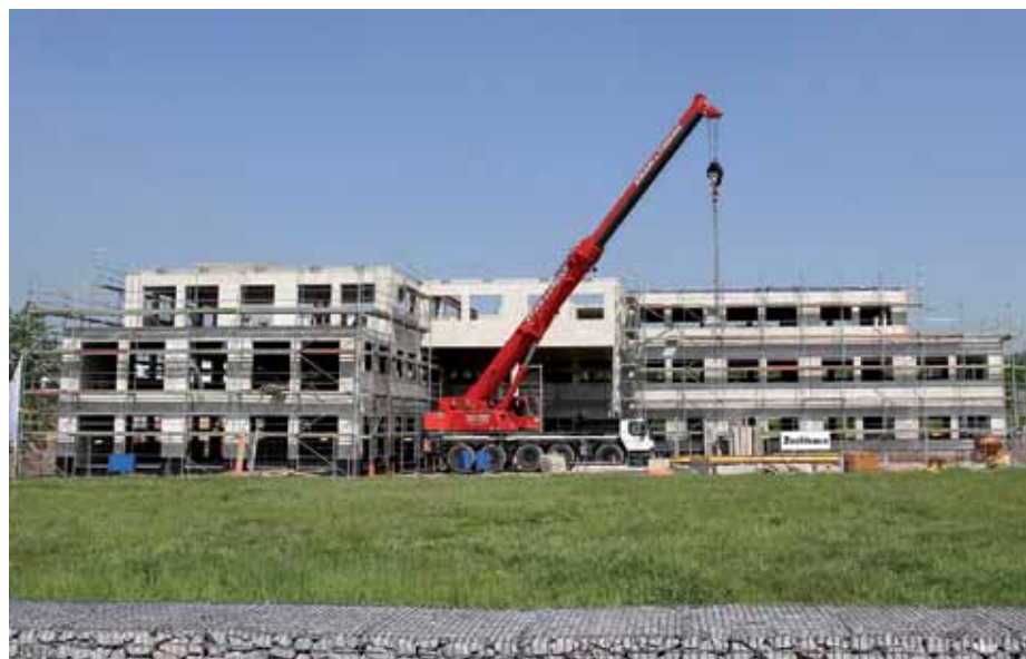
Am 22. Februar 2012 erfolgte der erste Spatenstich, mittlerweile schreiten die Bauarbeiten voran, und es zeigt sich, wie das Kompetenzzentrum für Gesundheitsberufe des Bundesverbandes selbstständiger Physiotherapeuten künftig aussehen wird. fobo-Bild: Molatta
